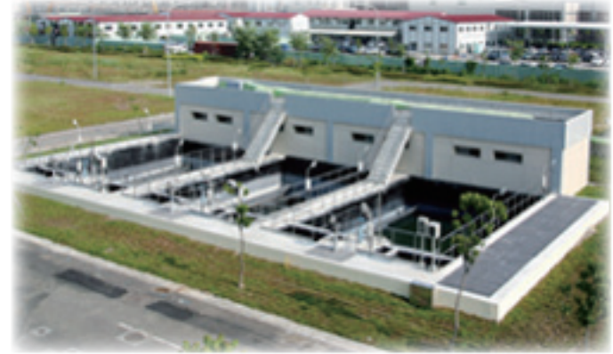
台南園區污水處理廠
