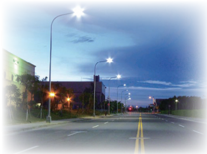
園區 LED 路燈現況
